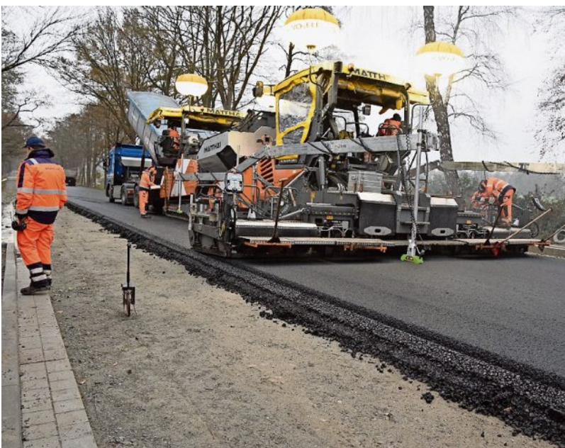
Die neue Asphaltenschicht wird eingebaut, hier in Höhe einer der beiden Bushaltestellen im Bereich Parnewinkel.
