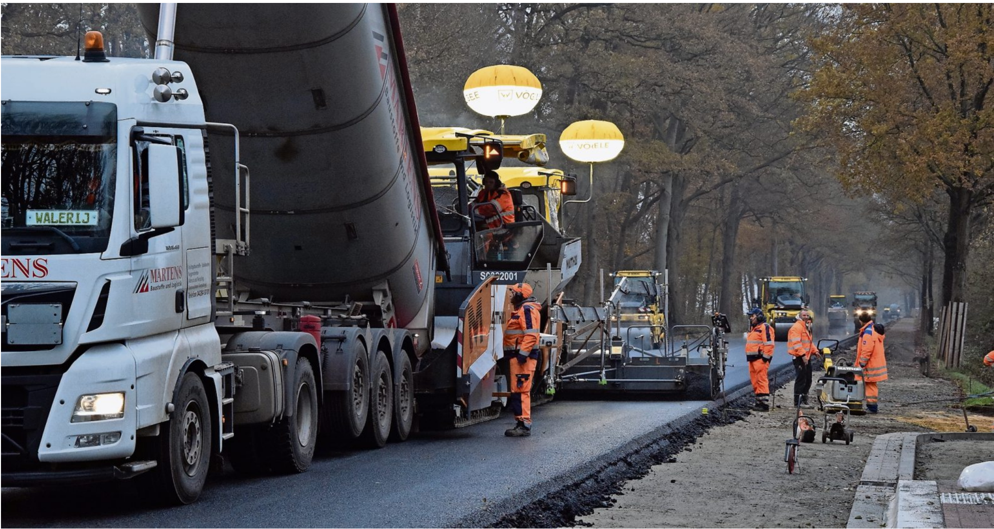
Die neue Asphaltenschicht ist aufgetragen, es geht sichtbar voran auf der Baustelle Bundesstraße 71. Fotos: Hilken
