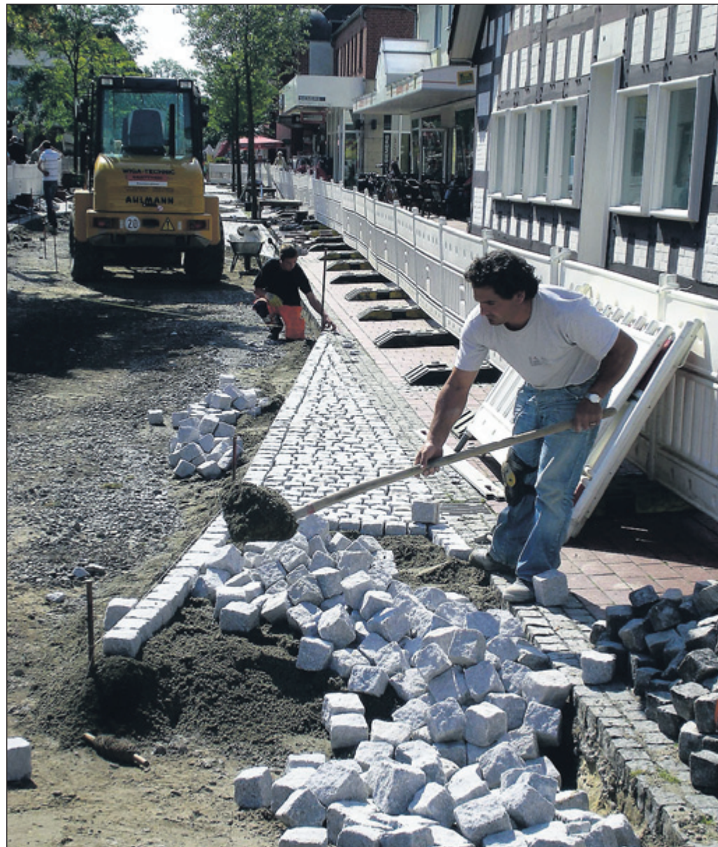
Schwerer und deshalb stabiler sind die neuen Granitsteine.
