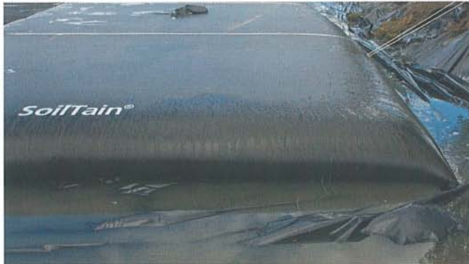
Geotext-Schlauch von Huesker zum Abtransport des Schlammes
