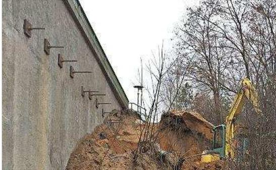
Auf dem Foto sind die Verschraubungen an der alten Brücke zu erkennen. Sie sollen ein Abrutschen der gegenüberliegenden Spundwände verhindern.
