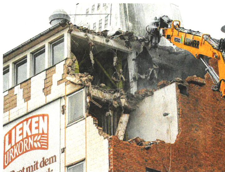
Wie eine riesige Schere schneidet der Bagger immer wieder in das feste Mauerwerk.
