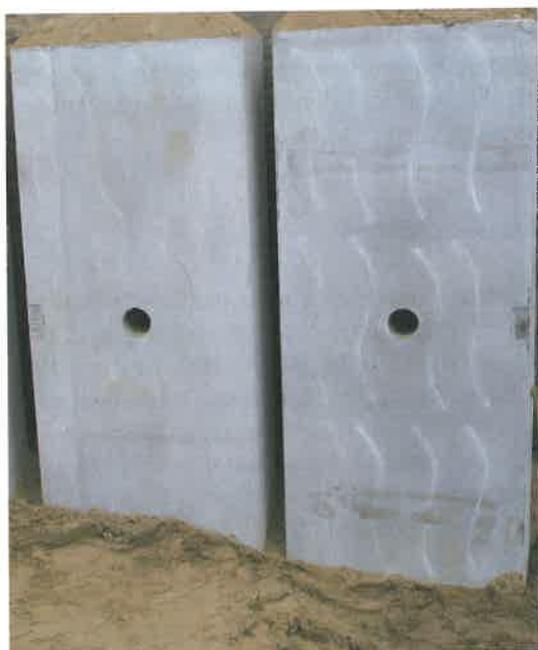
**Bild 4** Ankerplatte aus Stahlbetonfertigteilen
