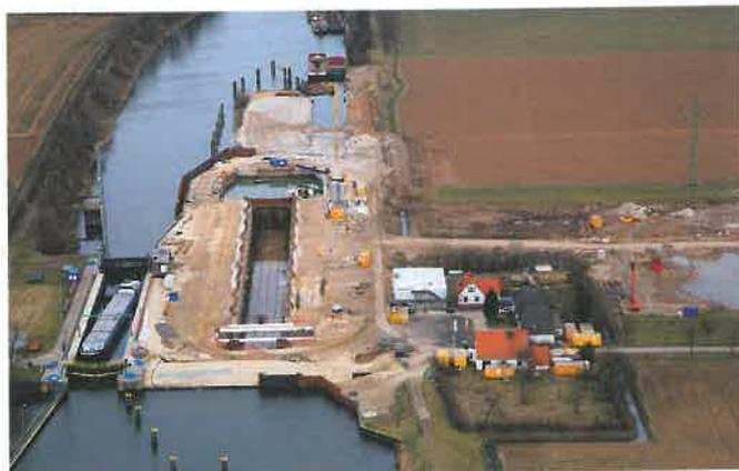
**Bild 5** Luftbild der Baustelle mit teilweise gelenzter Baugrube
