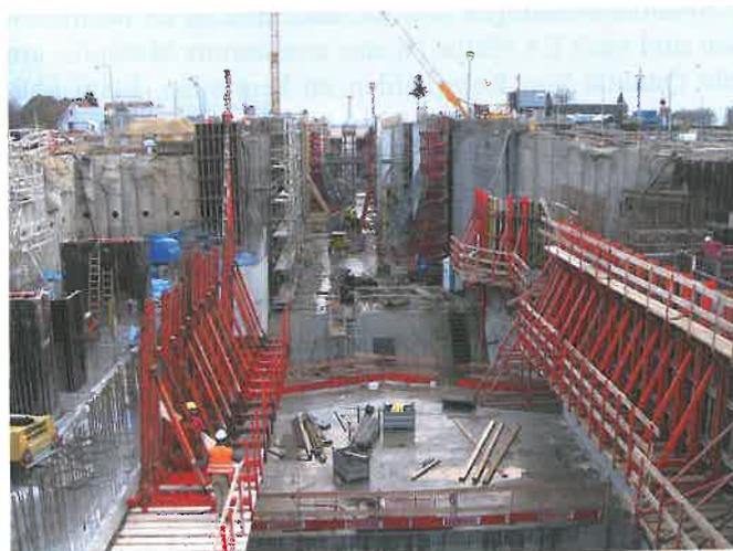
**Bild 6** Schalungsarbeiten (Blick vom Untertaupt in die Kammer)
