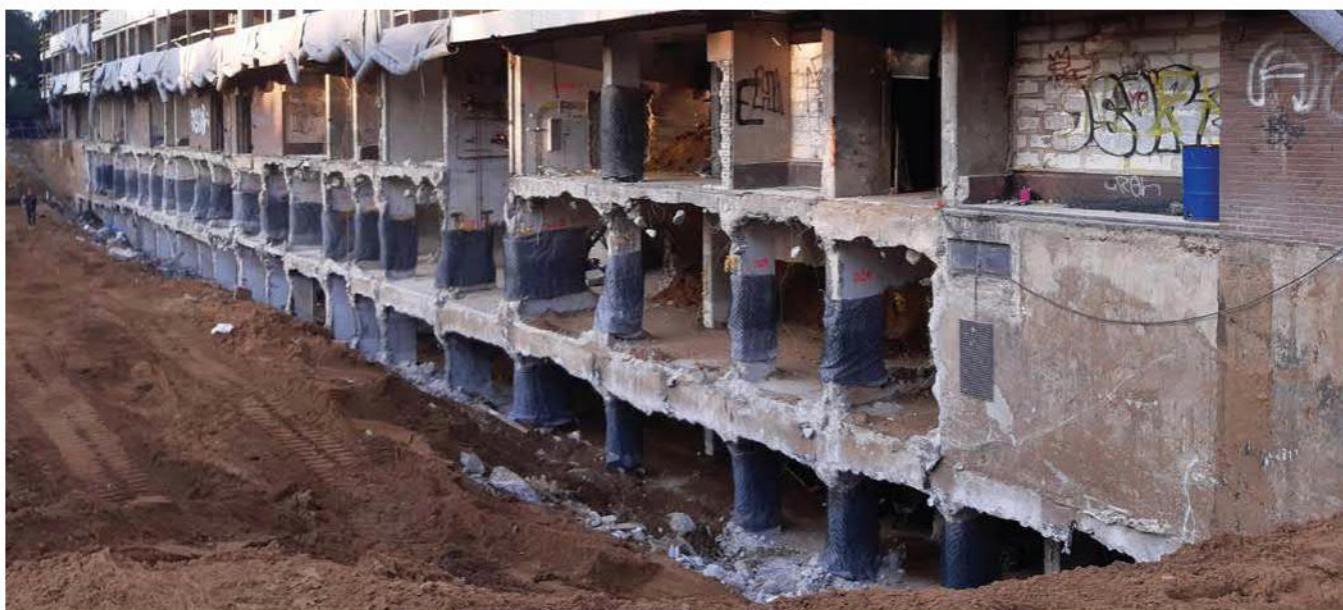
Vorbereitung der Abdeckungen, Foto: Thüringer Sprenggesellschaft mbH
