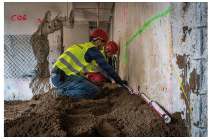
Ladearbeiten – angelegte Ladungen, Foto: Toma Babovic
